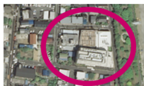
平成19年 改築工事終了後
